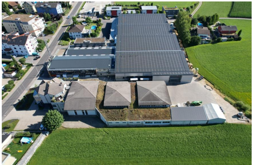
Abbildung 37: Der bestehende Betrieb mit realisierter grossflächiger PV-Anlage der Meyer BlechTechnik AG in Grosswangen (Blick Richtung Süden) | Quelle: Meyer BlechTechnik AG
